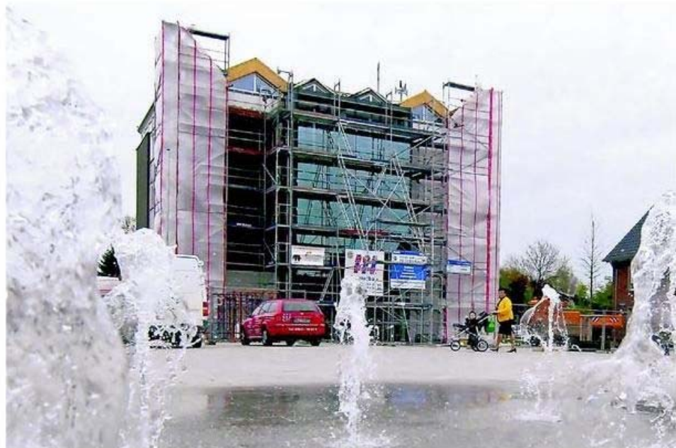
Noch ist das Weezer Rathaus eingerüstet für die Sanierung.
