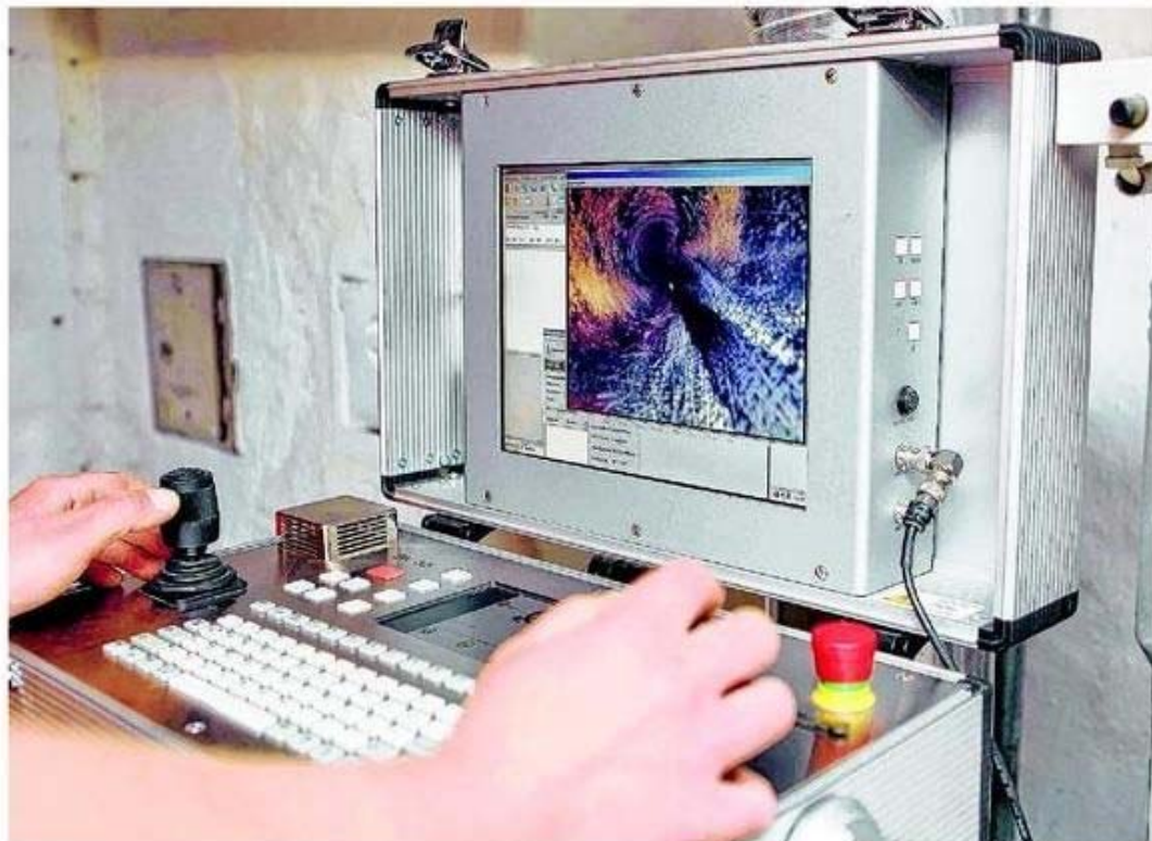
Mit einer Joystick-Steuerung wird eine Kamera durch die Kanäle gesteuert. So kann die Dichtheit überprüft werden. Dieses Verfahren empfehlen die Fachleute aus der Gelderner Verwaltung.
