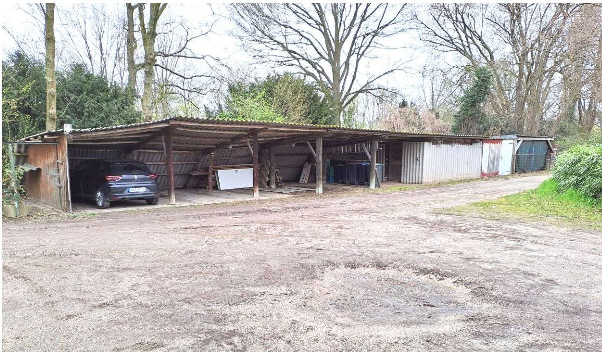
Abbildung 9: Schuppen, überdachte Stellplätze an der westlichen Plangebietsgrenze (eigene Aufnahme, 27.03.2024)
