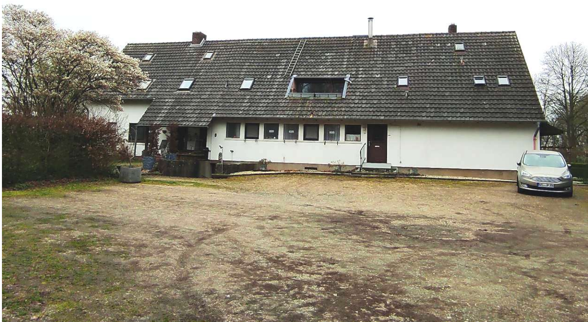
Abbildung 6: Nördliche Gebäudeseite und Erschließungsflächen (eigene Aufnahme, 27.03.2024)
